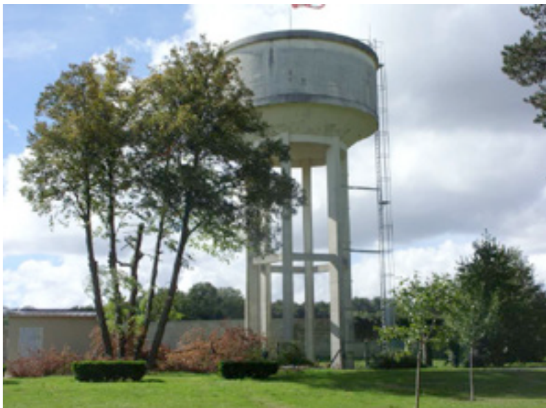
Le grand réservoir sur pied
